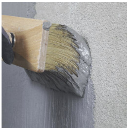
Aanbrengen van een contactlaag met borstel of kwast.
