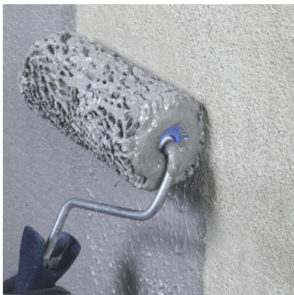
Aanbrengen van een contactlaag met een roller.
