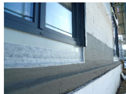
Afdichting van de overgang van een laag raam naar de sokkel met PCI Barraseal Turbo en PCI Pecithene Vliesband
