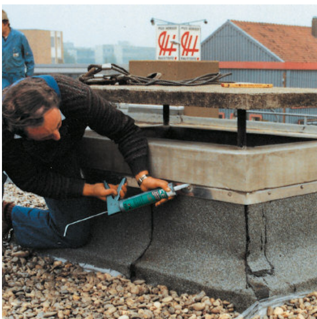
Elastisch afdichten van aansluitvoegen beton/roestvast staal bij een schoorsteen.
